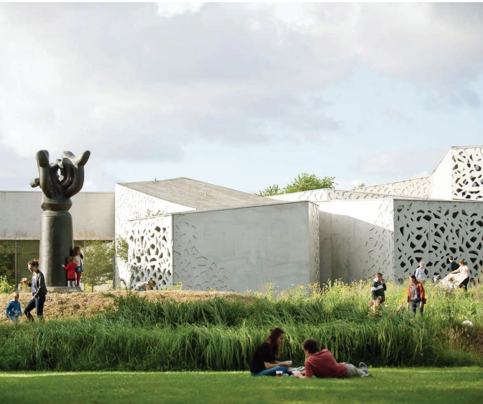
Vue extérieure du LaM, Villeneuve d'Ascq. À gauche : Jacques Lipchitz Le Champs Des Voyelles , 1931-1932 © Estate of Jacques Lipchitz. © Manuelle Gautrand architecture
