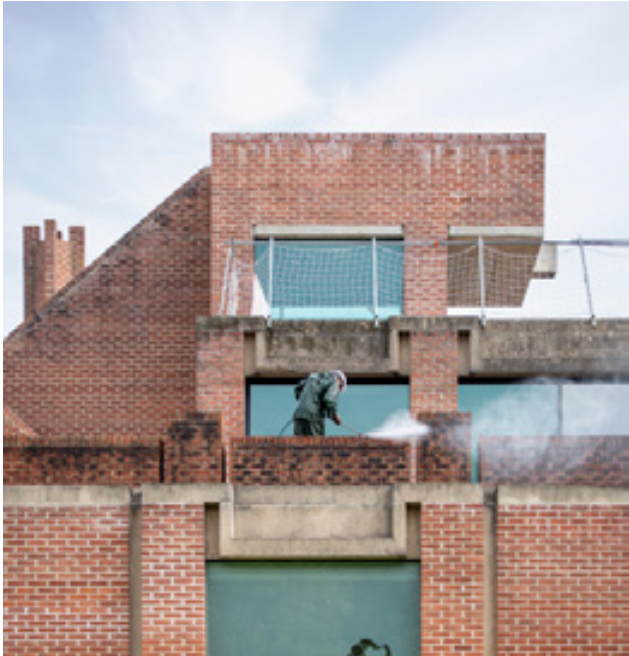
Travaux au LaM en 2024. Photo : N. Dewitte / LaM
